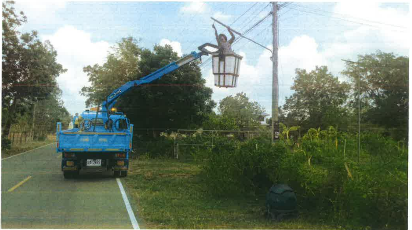
รายงานประจำเดือนพฤษภาคมการซ่อมแซมไฟฟ้าสาธารณะภายในตำบลหนองบัวบาน หมู่ที่ ๔,๑
