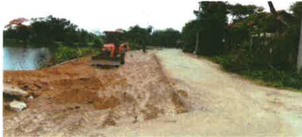
ภาพถ่ายขณะดำเนินการปรับระดับพื้นทาง
