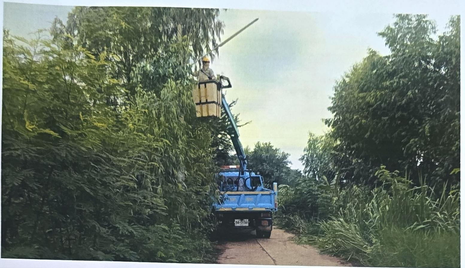
รายงานประจำเดือนกรกฎาคมการซ่อมแซมไฟฟ้าสาธารณะภายในตำบลหนองบัวบาน หมู่ที่ ๖
