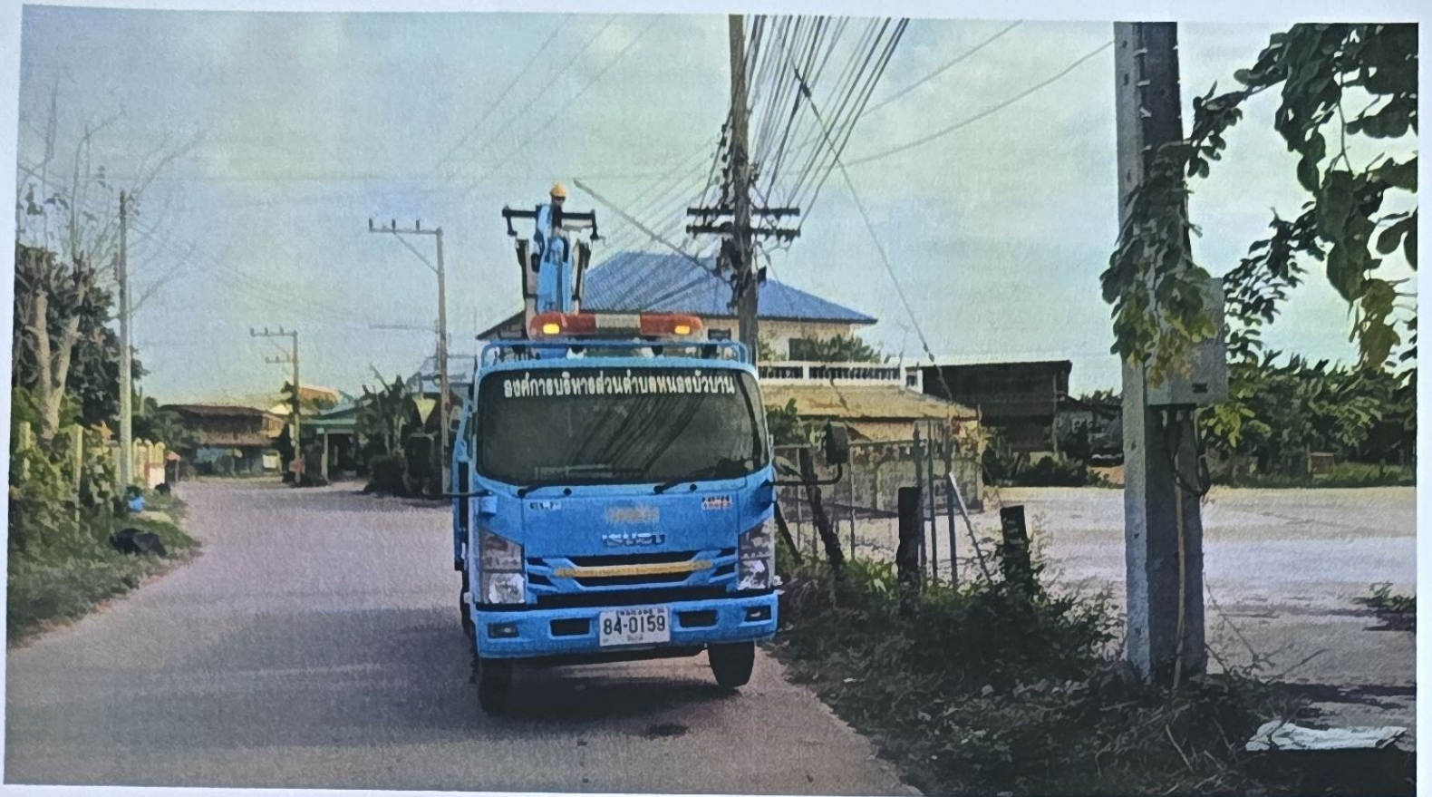
รายงานประจำเดือนกรกฎาคมการซ่อมแซมไฟฟ้าสาธารณะภายในตำบลหนองบัวบาน หมู่ที่ ๗,๒
