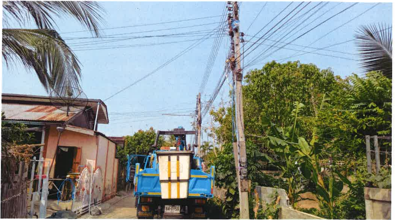
รายงานประจำเดือนมีนาคมการติดตั้งโครงไฟฟ้าสาธารณะภายในตำบลหนองบัวบาน หมู่ที่ ๑๑
