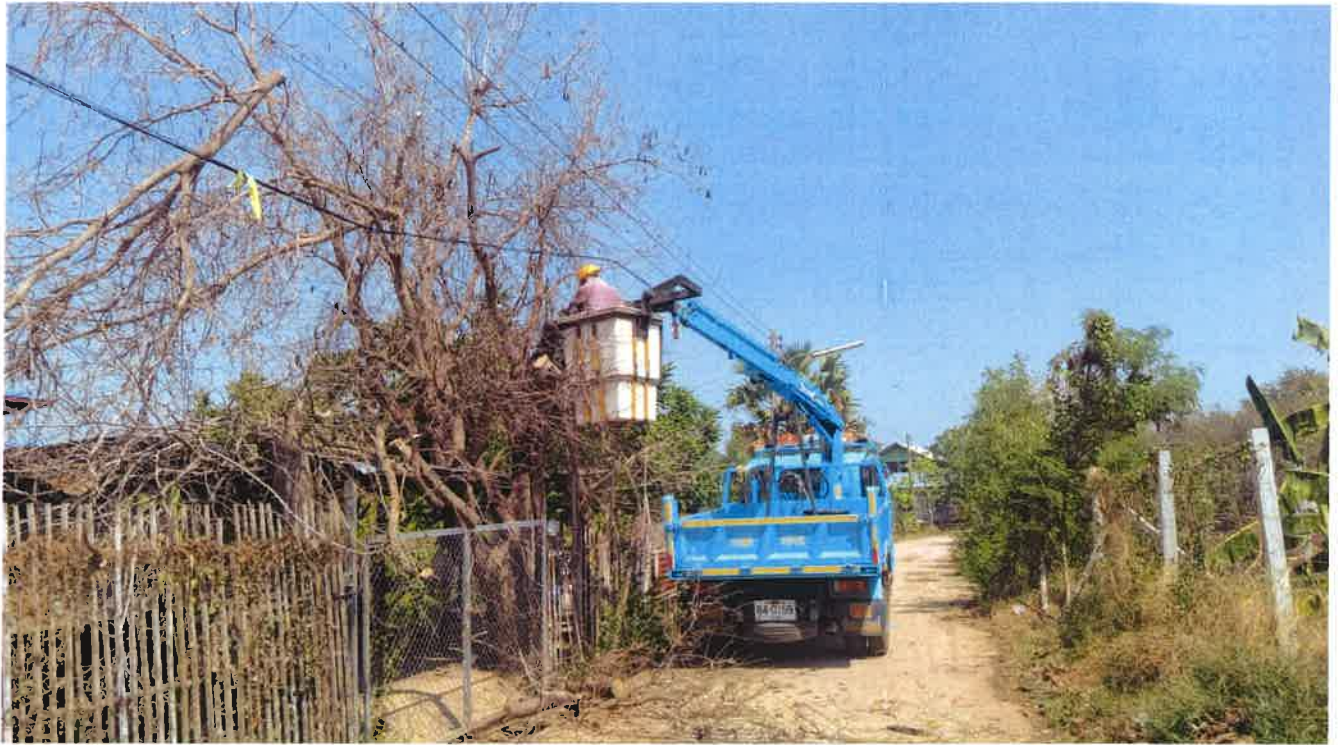
รายงานประจำเดือนมีนาคมการตัดแต่งกิ่งไม้ใกล้สายไฟฟ้าแรงต่ำตำบลหนองบัวบาน หมู่ที่ ๔
